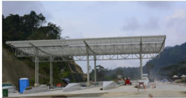
Así lucía la estructura a mediados de marzo.
